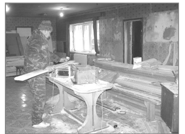
Работы на отделке помещений лыжной базы еще много, но многое уже сделано.
