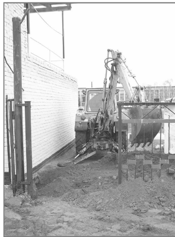
Завершается прокладка водопровода к павильону-раздевалке на стадионе.
