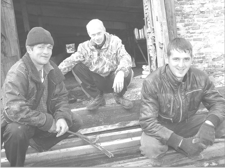
Стройбригада «Нивы»: Владимир КАБАЕВ, Виктор ПОПОВ, Антон КАБАЕВ – занята ремонт коровников. Один из них готов к приему стада, второй – в процессе восстановления. Фото Владимира КОНЮХОВА.
