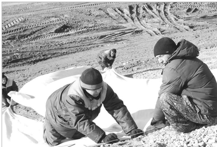
Строительство подъездных путей включает в себя большой объем работ. В их числе – укладка укрывного материала и установка георешетки для укрепления насыпи. Во время сильного ветра справиться с укладкой материала сложно, но при наличии навыков и терпения – возможно.
