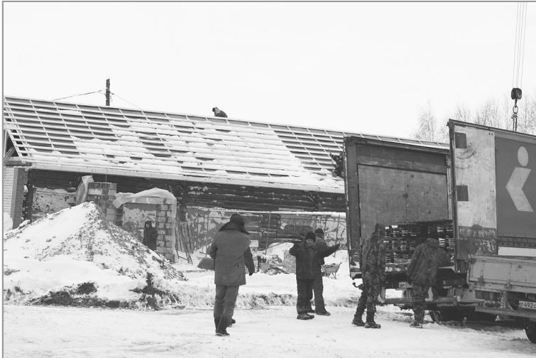
Строительный процесс не должен останавливаться, поэтому здесь постоянно заботятся о своевременной доставке материалов.
