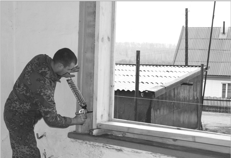
Идет монтаж пластиковых окон.
