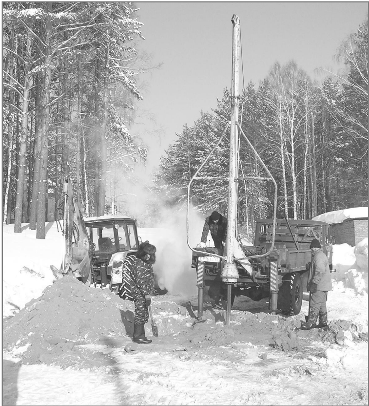
Работы по отогреву замерзшего водопровода к лыжной базе продолжаются. Директор ООО «Коммунальщик» А.А. Сысоев говорит, что в решении этой проблемы им оказывают содействие другие службы, в частности, «Алтайкрайэнерго». Фото Владимира КОНЮХОВА.
