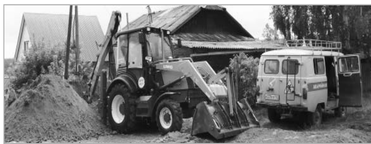
МУП ЖКУ Троицкого района ведет работы по прокладке 150 метров новой водопроводной сети по переулку Лермонтова — проезду Западному в райцентре.
