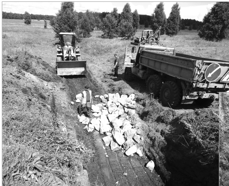
С начала августа ведутся дорожные работы на дороге от райцентра до федеральной трассы.
