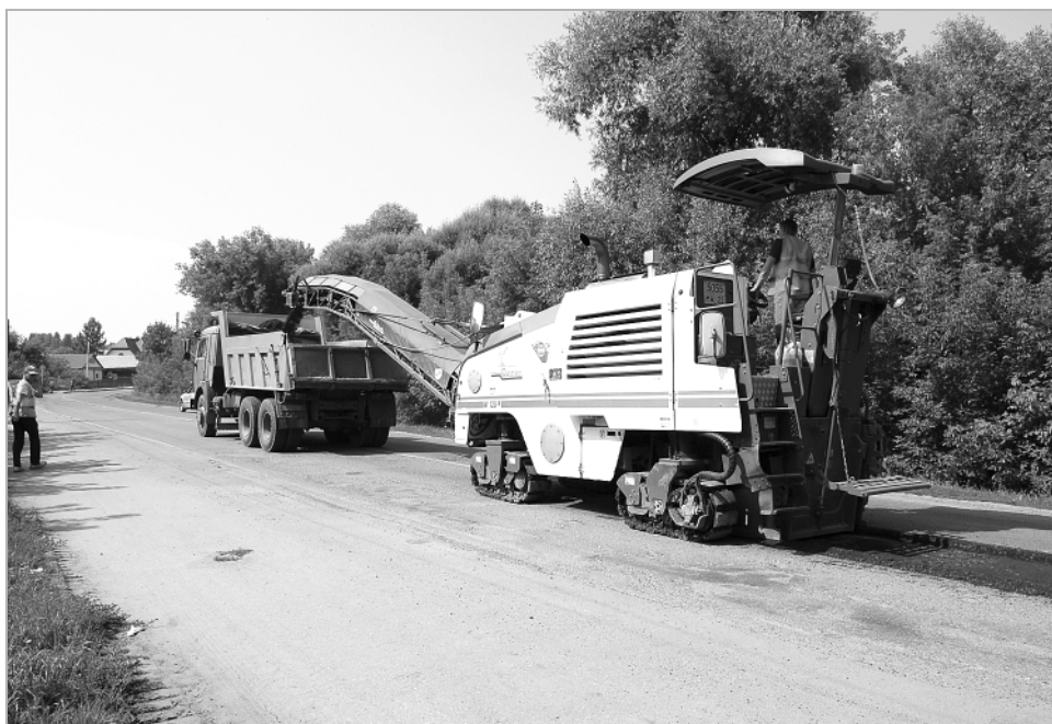
10 августа на участке дороги около моста в селе Троицком работала дорожная техника. Для снятия износившегося слоя асфальта применяется специальная машина, называемая у дорожников фрезой. Она не только снимает старый асфальт, но и грузит его в самосвал. За счет средств краевого и районного бюджетов (общая сумма – 3 млн. 425 тыс. руб.) будет капитально отремонтирован участок дороги.
