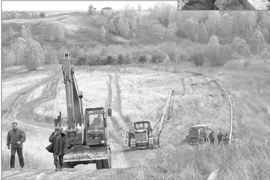
В Чесноковом логу ведутся земляные работы. Подрядчики говорят, что ускорят темпы по строительству газопровода до Белого. На снимке сверху – работник подрядной организации ОАО «Спецгазремстрой» выполняет изоляцию стыков газопровода в Белом.
