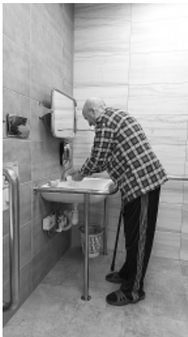
Для людей с инвалидностью в Комплексном центре г. Славгород обустроена санитарно-гигиеническая комната.
