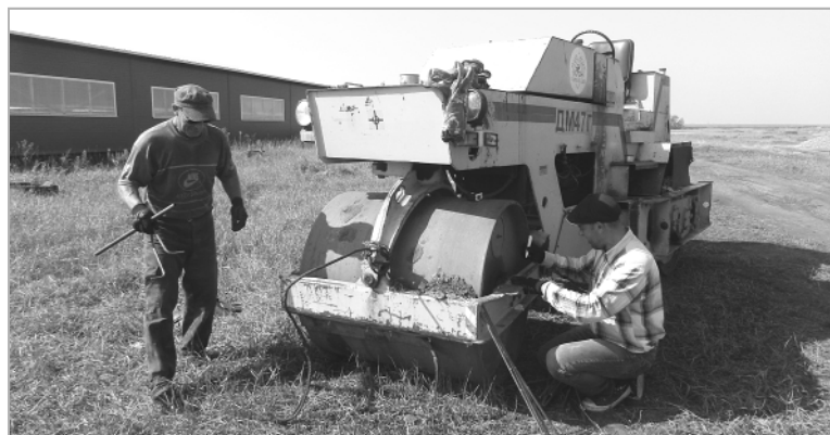
Стройка в «Казачьей станице» идет полным ходом: с помощью асфальтоукладчика утрамбовывается площадка, на которой будет располагаться кормовая стол для скота.
