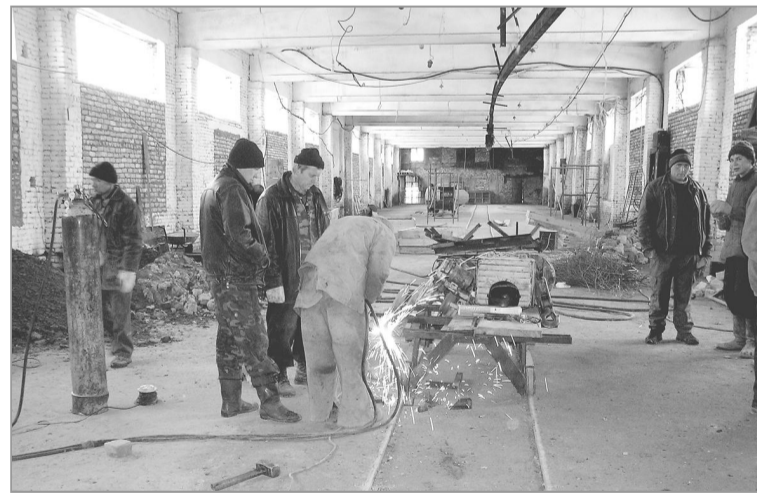
А пока здесь полным ходом идет реконструкция цеха по обработке древесины.
