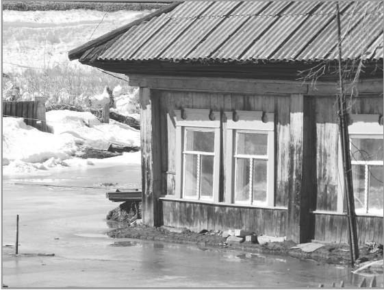
Это не разлив реки, просто кто-то засыпал у себя в ограде кювет, а в этом доме на ул. Линеинной вода из подполья разлилась поверх пола.
