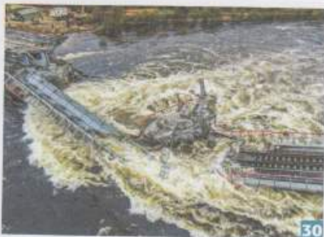
Разрушенный железнодорожный мост
