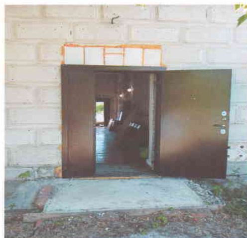
Фото № 10 Входы(выходы) с улицы эвакуационный №2
