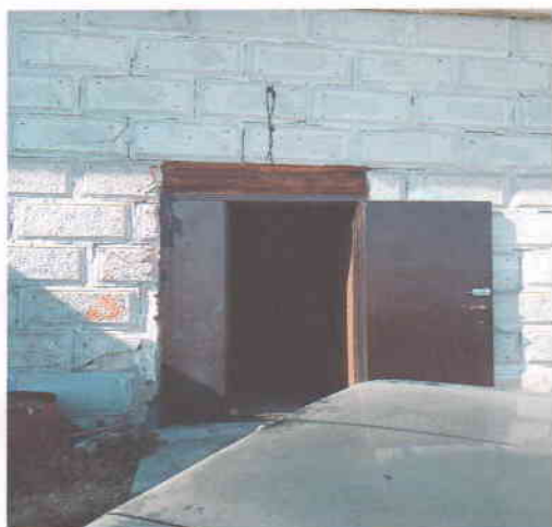
Фото №9 Входы(выходы) с улицы эвакуационный №1
