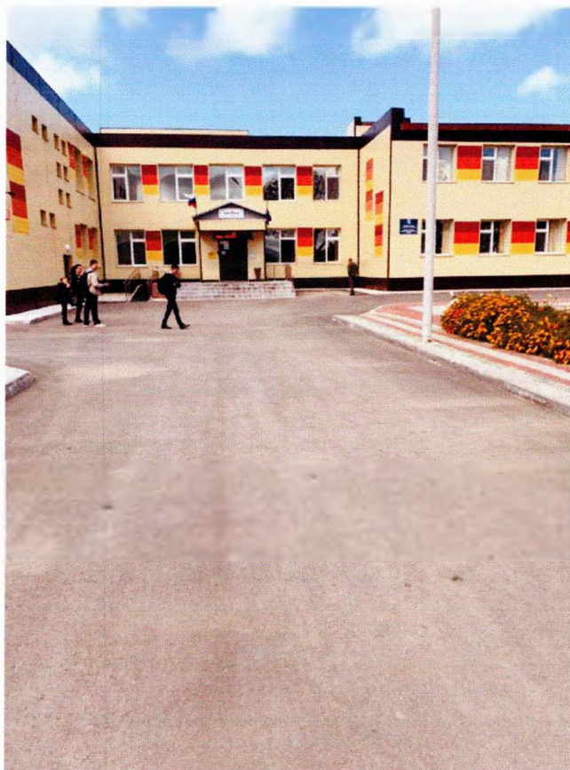
Безбарьерный путь до главного входа в школу
