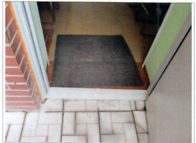
Фото №10 – Входная дверь
