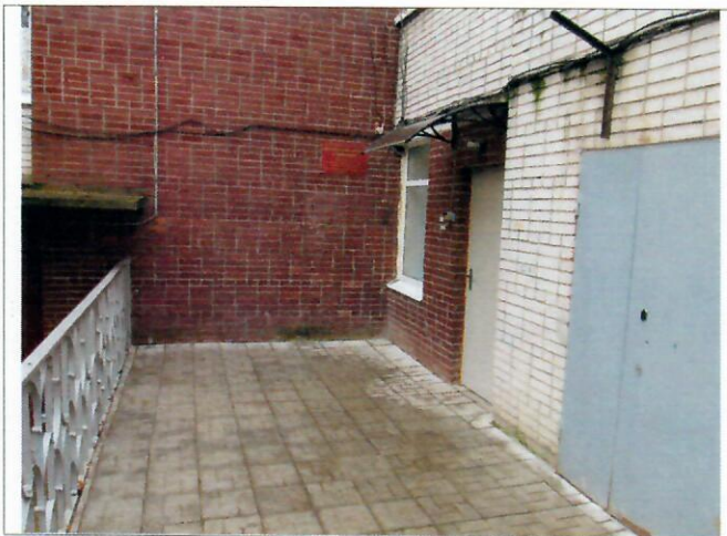
Фото №9 — Входная площадка.
