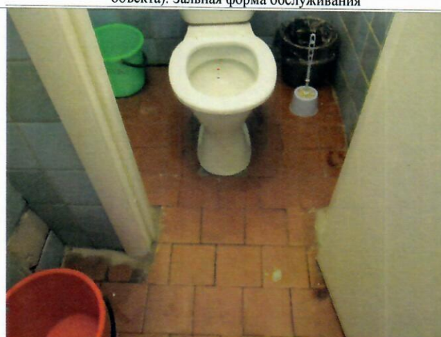
Фото №22 – Санитарно-гигиеническое помещение
