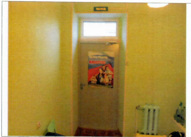
Фото №13 – Внутренние двери. Эвакуационный выход.
