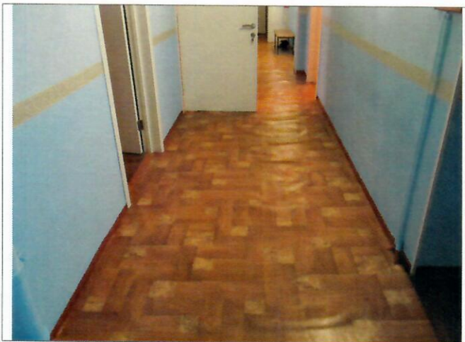
Фото №11 – Путь (пути) движения внутри здания (в т.ч. пути эвакуации)
