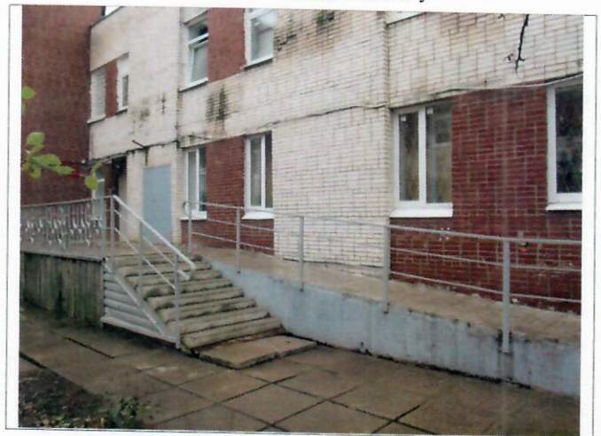
Фото №4 – Входная площадка.
