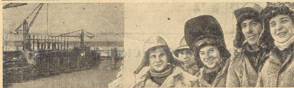
КРАСНОУРАЛЬСКИЙ КРАЙ. Соревнуясь в честь XXIV съезда КПСС, коллектив «Хантайгэстроя» пересмотрел свои обязательства и решил завершить строительство Усть-Хантайской гидроэлектростанции на год раньше срока.
