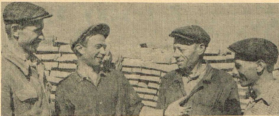
Ударными темпами работает на строительстве очистных сооружений бригада Я. Шелепина из ШСУ № 3.
