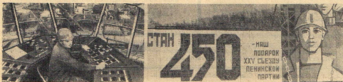
Кемеровская область. Полным ходом идут работы на Всесоюзной ударной комсомольской стройке — средне-сортном стане «450» Западно-Сибирского металлургического завода. Он будет одним из крупнейших в отечественной металлургии. Его производительность — полтора миллиона тонн проката в год.
