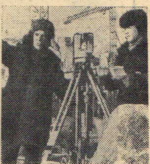
Амурская область. На Всесоюзной ударной комсомольской стройке — Зейской ГЭС полным ходом идут монтажные и бетоноукладочные работы.
