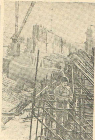
На снимке: сооружение судоремонтного цеха Новосибирской электростанции.
