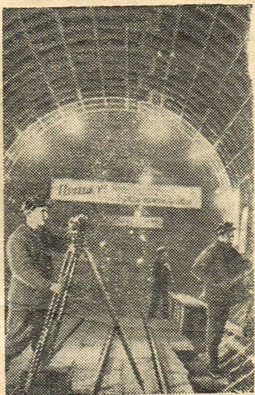
Ростовская область. На Донском магистральном канале по-стахановски работают горнопроходческие бригады «Донтоннельстроя».
