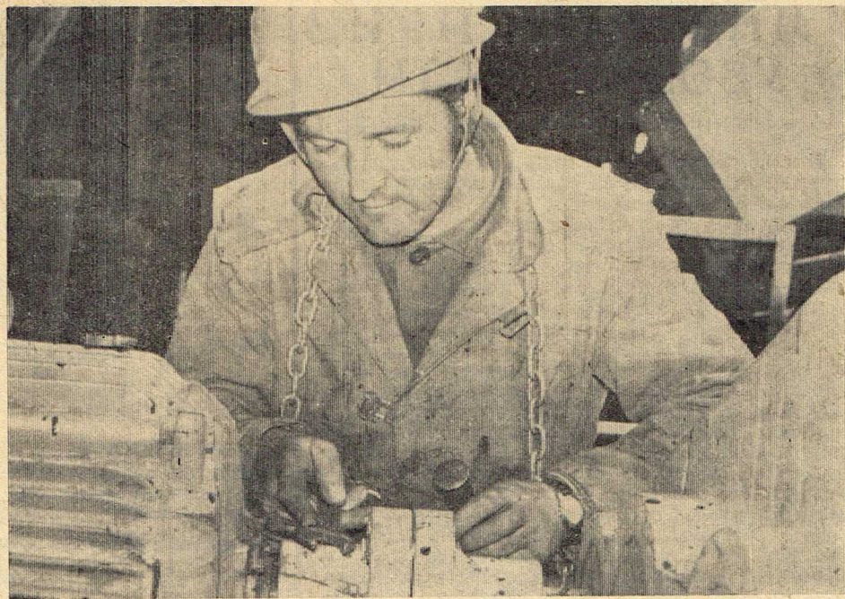
В строительстве многих важных объектов участвовал Василий Иванович Лапин — слесарь-монтажник Североуральского участка треста «Союзшахтоспецмонтаж». Он работал на девятой, тринадцатой, шестнадцатой шахтах, на сооружении телевизионной вышки-ретранслятора. Как специалист высоко ценится В. И. Лапин в бригаде В. С. Захарова, ведь кроме своей основной он владеет еще двумя специальностями — стропальщика и газорезчика.
