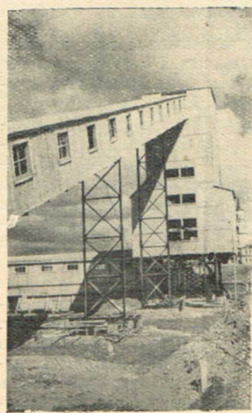
Трест Бокситстрой укрепляет производственно-техническую базу. Недавно введен в эксплуатацию бетонный завод суточной производительностью более 1,000 тонн.
