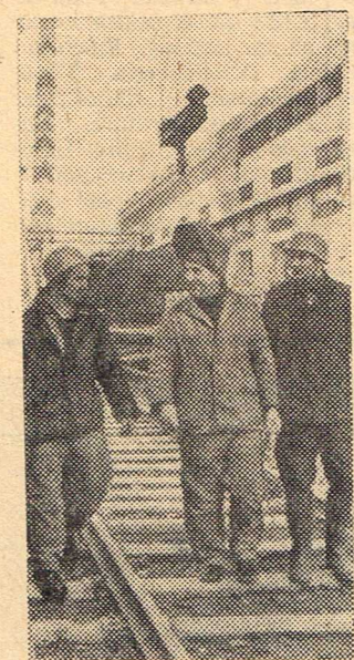
ПОДАРОК СТРОИТЕЛЕЙ ГРЭС ЮБИЛЕЮ
