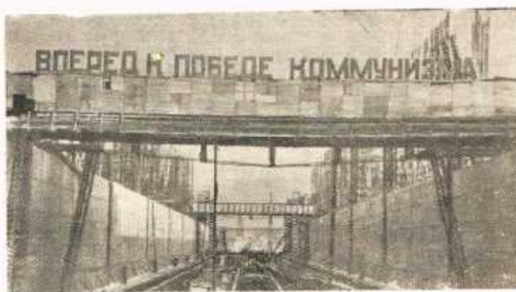
Куйбышевгидрострой. Первый пусковой объект Куйбышевского гидроузла — двухкамерные судоходные шлюзы — вступит в строй весной 1955 года. Сейчас на шлюзах идет монтаж гигантских створок рабочих ворот, установка механизмов управления, укладка бетона и монтаж арматуры на верхних ярусах.
