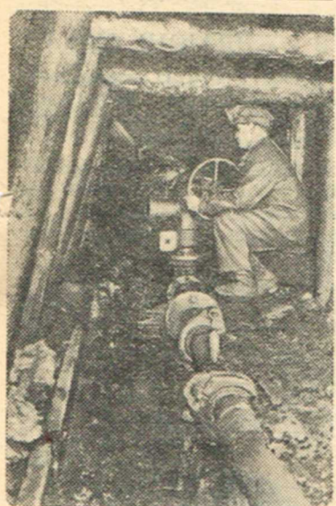
Кемеровская область. На двух шахтах Кузбасса — «Тырганские уклоны» и «Полысаевская Северная» — применяется подземная гидравлическая добыча угля.
