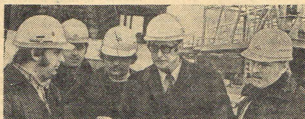
Корельская АССР. На севере республики завершилось строительство второй очереди Пяозерского лесопроизводства. В его сооружении принимает участие финская фирма «Перусоухтюма».
