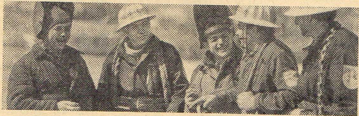
В Магадане сооружается цех алюминиевых панелей. Здесь будет производиться цветное анодирование алюминиевых конструкций для интерьеров и фасадов сборно-разборных зданий.
