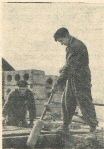
На снимке: Виктор Величко и Николай Фунтиков за изготовлением трехдырчатых бетонных блоков.
