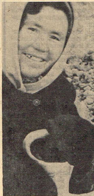
Бригада землекоп-бетонщиков из СМУ-7, руководимая Г. А. Шилиной, занимается сейчас разработкой грунтов на строительстве теплотрассы к центральной котельной. С заданиями бригада справляется успешно.
