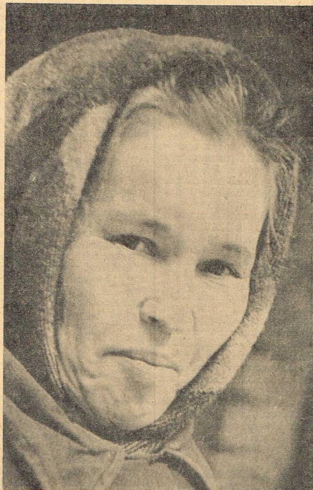
Мария Семеновна СТЕПАНОВА — рядовая труженица строительной бригады участка № 2 СУ № 5. Много лет она работает в тресте «Бокситстрой» на отделке промышленных и жилых зданий. Большой опыт помогает ей хорошо справляться с работой.
