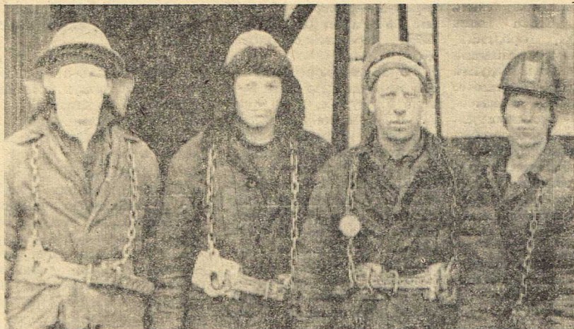
● НА СТРОИТЕЛЬСТВЕ ВЕРТИКАЛЬНЫХ СТОЛБОВ
