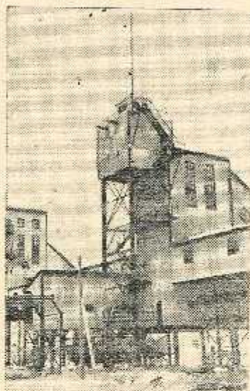
На снимке: надшахтные сооружения шахты № 7 Калининского рудника Североуральского бокситового рудоуправления. Фото И. Исакова.
