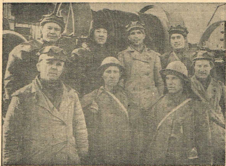
На ударной стройке — вертикальной шахте № 15—15 бис — трудится бригада монтажников с участка «Уралэлектромонтаж», руководимая Василием Васильевичем Афанасьевым. Сейчас она ведет работы по прокладке и креплению силовых кабелей в клетевом стволе шахты, монтирует оборудование.
