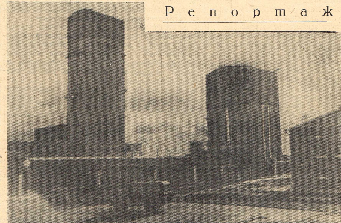
Общий вид вертикальной шахты № 15—15 бис.
