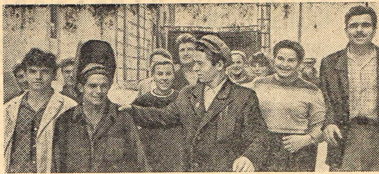
НА СНИМКЕ: строители Киевской-Комсомольской ГЭС.
