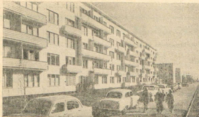
МОСКВА. Этот красивый пятиэтажный жилой дом построен в 10-м экспериментальном квартале Новых Черемушек. Особенность этого здания в том, что оно смонтировано из отдельных блок-комнат заводского изготовления.
