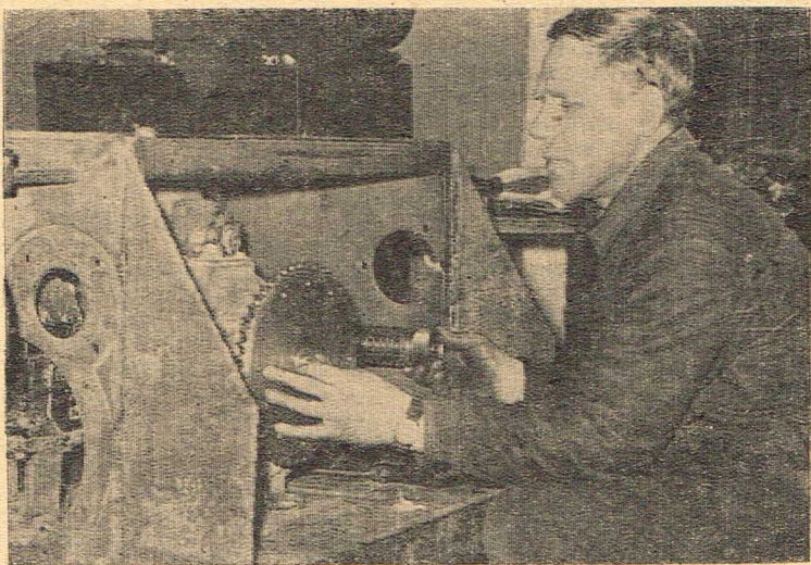
Тяжелый ручной труд укладчиков кирпича скоро будет облегчен. Слесарь кирпичного завода Александр Павлович Соболев давно работает над изготовлением автоматического укладчика. Автоматическая линия для резки и сэмки кирпича-сырца почти готова, с ее пуском освободятся 5 человек-укладчиков. За десять лет работы на заводе Александр Павлович подал и внедрил более 25 рациональных предложений. Он неоднократно награждался Почетными грамотами.
