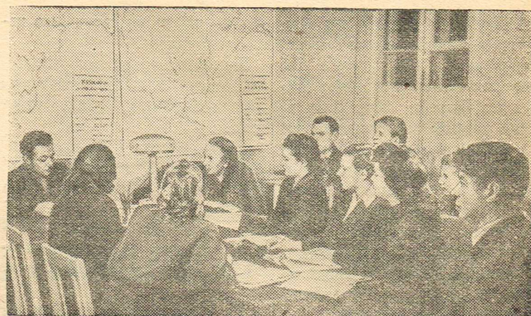
Тахиа-Таш, Строители Главного Туркменского канала изучают материалы XIX съезда КПСС. На снимке: пропагандист Б. Захарьянц (слева) занимается с кружком строителей.
