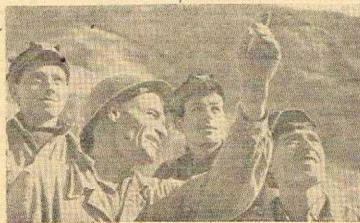
НА СНИМКЕ: передовая бригада бетонщиков на строительстве Нурекской ГЭС. Слева направо: М. Новоселов, бригадир П. Блохин, А. Жеребцов и В. Шутенко.
