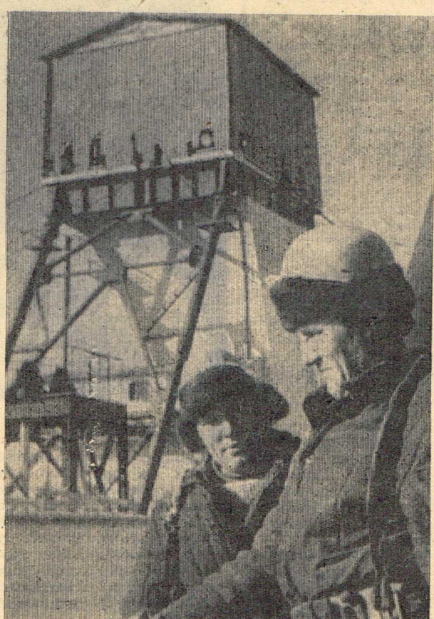
Проходка главного ствола зависит от окончания монтажа проходческого комплекса КС-2У40 и от того, как скоро строители бригады В. Г. Васильева выполнят обшивку копра специальными щитами из дерева и металла. В этом коллективе трудятся монтажники А. В. Ерохин (слева) и П. Г. Пронин.
