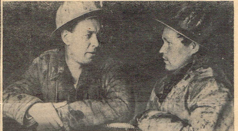
Строительство вспомогательного ствола десятой шахты рудника ведет шахтостроительное управление № 3.
