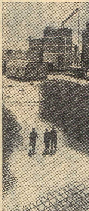
ТУРКМЕНСКАЯ ССР. Недалеко от Мары, на берегу Каракумского канала, раскинулась огромная строительная площадка. Здесь сооружается крупнейшая в республике электростанция.
