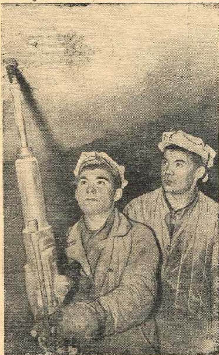
Забойная бригада четвертой шахты Второго Северного рудника под руководством Василия Ивановича Ижбулина одна из первых освоила крепление выработок металлическими болтами. «Специалисты по креплению болтами» — так говорят об этом коллективе.
