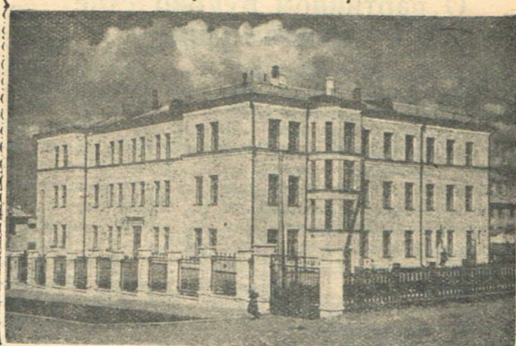
Красноуральск. Новое здание поликлиники в больничном городке.
