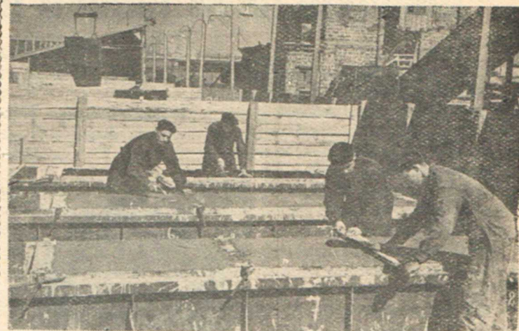
Краснотурьинск. На снимке: изготовление крупных стеновых блоков на заводе железобетонных изделий треста Базстрой.
