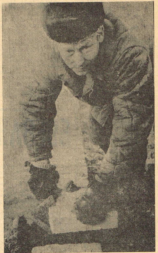
В поселке Черемухово строители ИСУ № 3 первого участка возводят детский комбинат на 280 мест. Одной из бригад каменщиков руководит Яков Александрович Шелепов. Хорошо организованный труд дает возможность каменщикам перевыполнять сменные задания на 20—25 процентов. НА СНИМКЕ: бригадир Я. А. Шелепов. Фото Ю. Романова.
