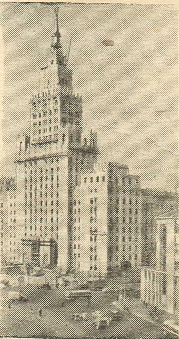
МОСКВА. Строительство высотного здания министерства путей сообщения у Красных ворот.
